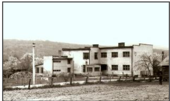
Škola v obci postavená v r. 1939
