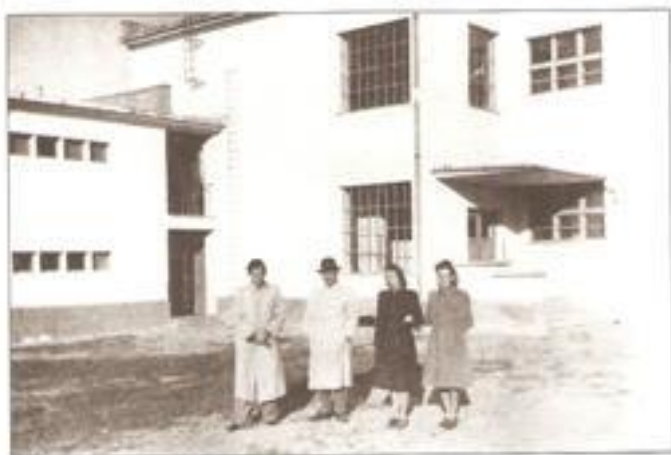
Obecná ľudová škola postavená v r. 1939
